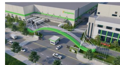
ハノイ新工場(建設中)
