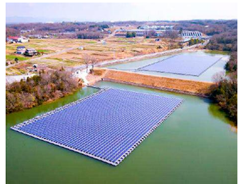
兵庫県小野市の水上フロート式メガソーラため池の上に太陽光パネルを浮かべている
