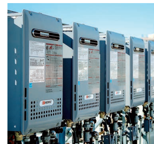
業務用給湯器設置の様子
