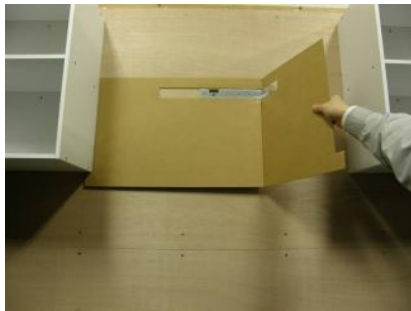
型紙で位置あわせ 固定金具を取り付け
