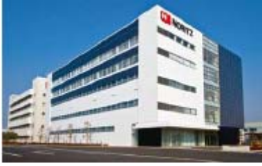
環境機器開発センター (2011年11月設置、64kW)
