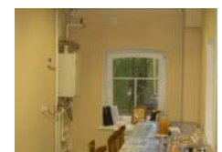
ロシア修道院にて給湯器設置
