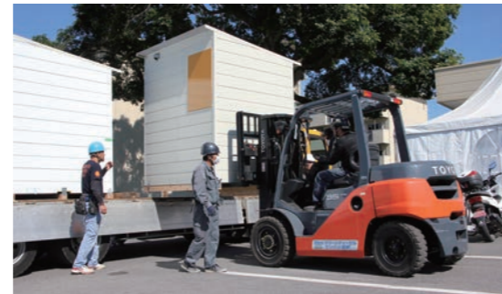
避難所へのシャワーブース設置の様子
