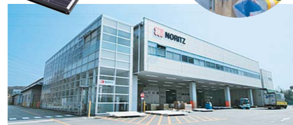
⑤ ノーリツ加古川工場
