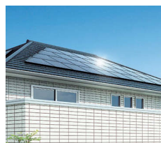
太陽光発電システム
