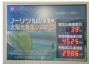
発電量表示パネル
