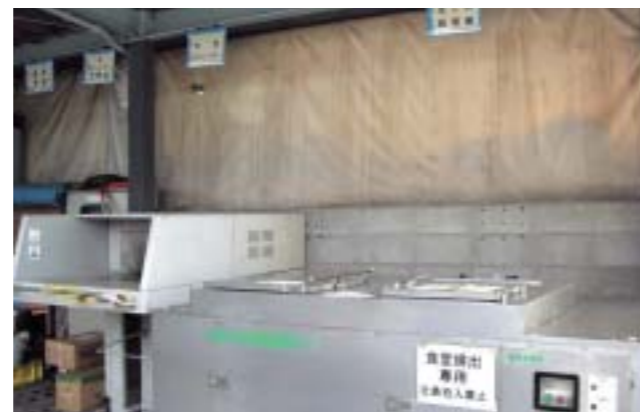
■ 生ゴミ処理施設
