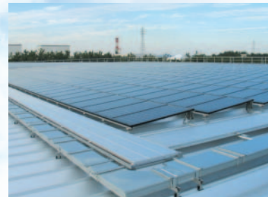
生産技術開発センター屋上
