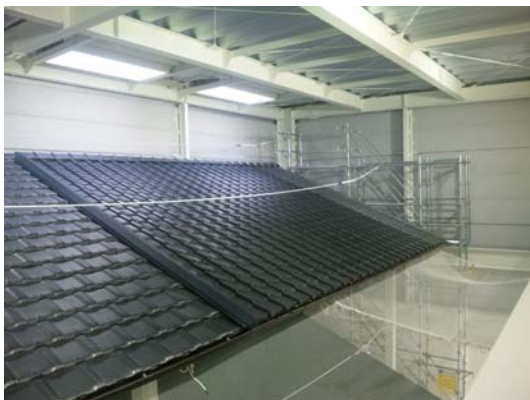
(施設内部に「模擬屋根」を設置)
