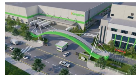
ハノイ新工場(建設中)
