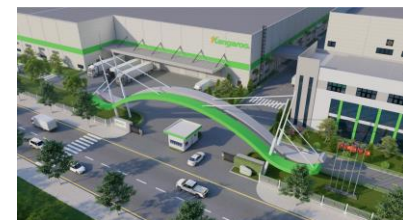
ハノイ新工場(建設中)
