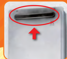
排気口に煤汚れ
