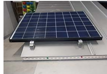
モジュール設置状態
