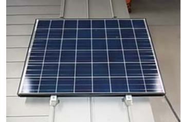
モジュール設置状態
